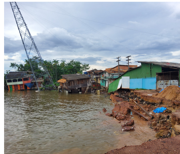
Figura 3.13: Erosão da margem do Rio Maratauíra, influenciado por regime de mesomárés, registrada em fevereiro de 2023, na cidade de Abaetetuba (município de Abaetetuba, estado do Pará). Fonte: Foto de Sheila Teixeira.
