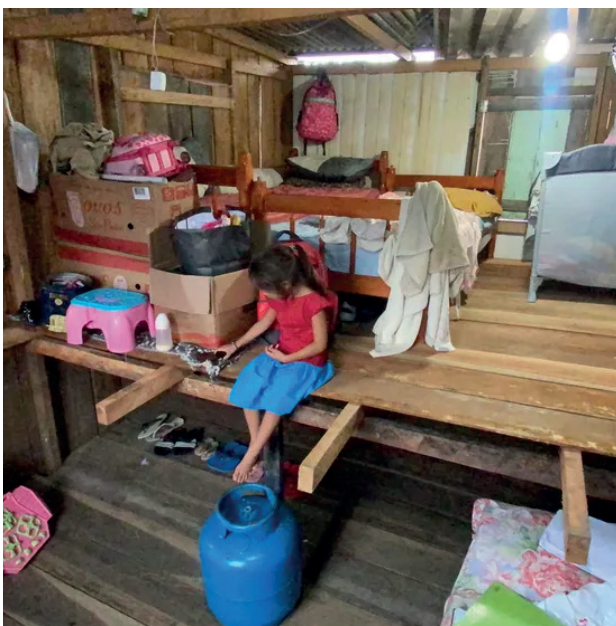
5.6: Maromba construída no interior de residência como forma de convivência com inundações fluviais. Cidade de Manaus (AM), 2025. Fonte: Foto de Patrick Marques (Marques, 2025).
