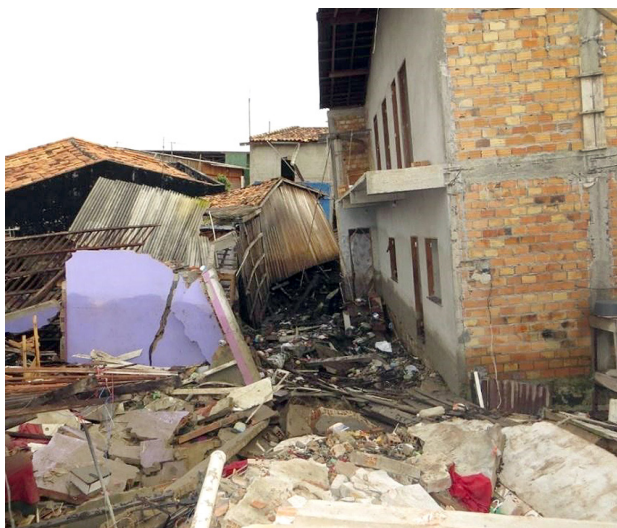
Figura 5.2: Perfil de solo antrópico formado por caroços de açaí, resíduos de madeira e lixo urbano, utilizado para moradia e exposto após colapso do aterro. Município de Abaetetuba (PA), 2014. Fonte: Foto de Dianne Fonseca.
