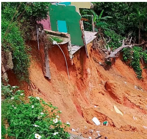
Figura 3.30: Deslizamento planar em solo friável, Manaus (AM). Fonte: Foto da Defesa Civil de Manaus (2025).
