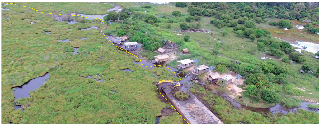
Figura 4.1: Ilha flutuante (delimitada pela linha tracejada amarela) isolando uma comunidade no município de Porto de Moz (PA), 2018. Fonte: Foto da Defesa Civil do Estado do Pará.
