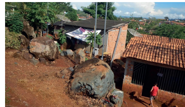
Figura 3.36: Moradias construídas em área com presença de blocos rochosos instáveis, que podem atingir as residências situadas abaixo. Parauapebas (PA), 2019. Fonte: Foto do acervo do projeto (2019).
