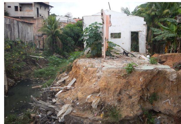
Figura 5.1: Perfil de solo antrópico aterrado com resíduos de madeira, serragem e moinha, utilizado para moradia e exposto após forte enxurrada. Município de Paragominas (PA), 2017. Fonte: Foto de Dianne Fonseca e Luciana Miyagawa.
