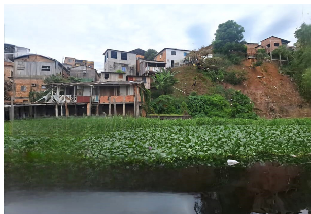
Figura 3.32: Moradias instaladas sobre escarpa fluvial instável na zona leste de Manaus (AM). Fonte: Foto da Defesa Civil de Manaus (2025).
