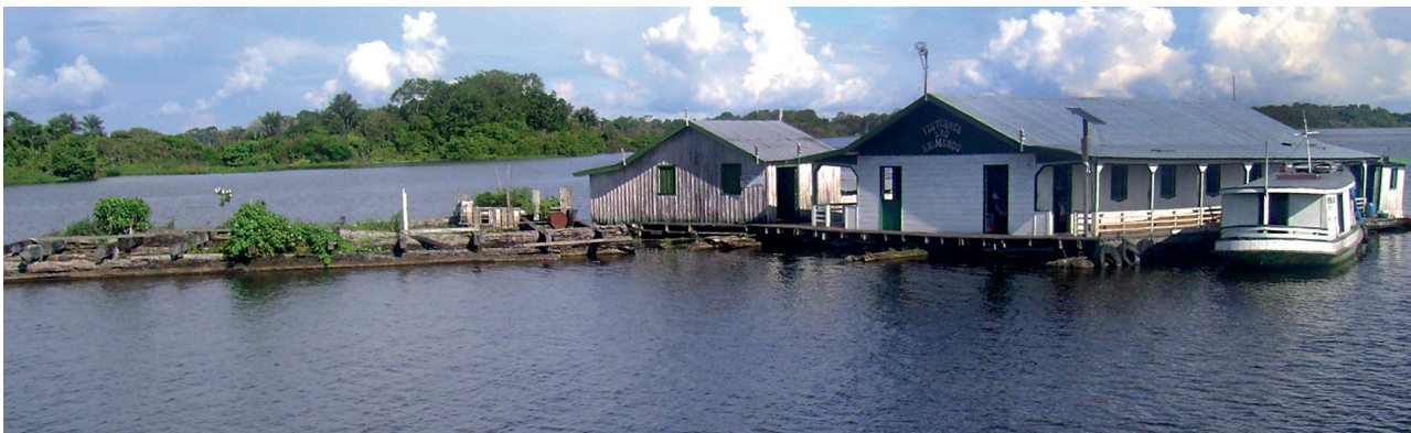
Figura 5.5: Casa com horta flutuante utilizada para moradia em área sujeita à variação do nível dos rios. Município de Manacapuru (AM), 2008. Fonte: Foto de Sheila Teixeira.
