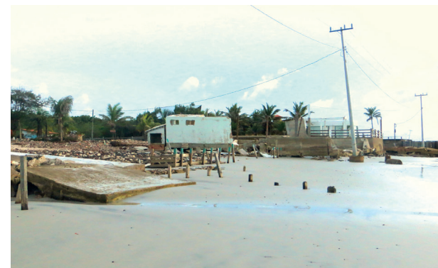
Figura 3.2: Residência e muro de contenção destruídos pela erosão costeira em 2015. Praia do Farol – município de Salinópolis – PA. Fonte: Sheila Teixeira.
