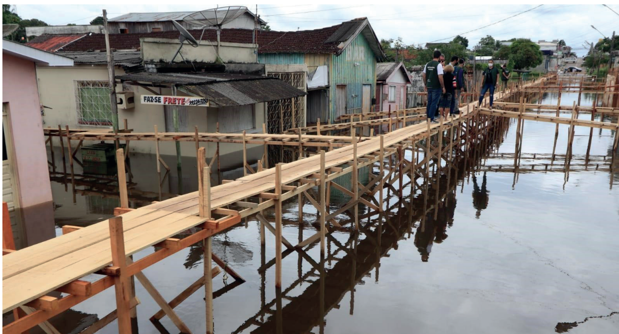
Figura 5.7: Sistema provisório de pontes construído para a locomoção da população durante inundação urbana. Município de Coari (AM), 2022. Fonte: Foto da Defesa Civil do Amazonas.
