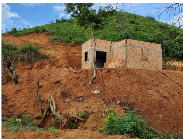
Figura 3.31: Corte em encosta para construção em área inclinada no município de Parauapebas (PA). Fonte: Foto do acervo do projeto (2022).
